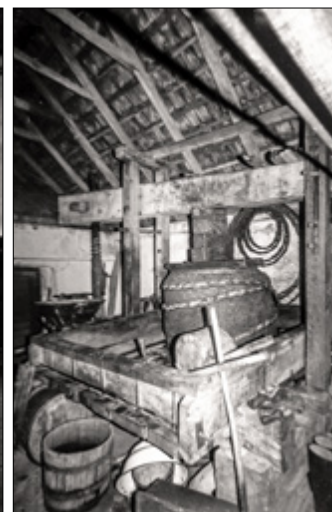
Szőlő préselése gúzsos préssel Jakab József pincéjében 1992-ben. A pince falazata tömés, eredetileg zsúptető fedte, de azt az 1960-as években cseréptetőre cserélték. A présházban meghagyták a régi gúzsos prést.
