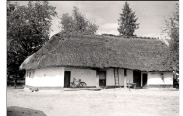
BALRA: 1810-ben épült, zsúptetős, füstöskonyhás, kémény nélküli lakóház a Rózsa utca 23. sz. alatt, 1960-ban. Fatalpas szerkezetű, sövényfalú, lopott tornácos épület.
