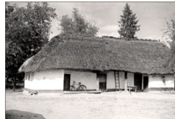
BALRA: Tömésfalú ház zsúptetővel Újnép-pusztán, 1960-ban. A szoba-konyha-kamra beosztású lakóház 1900 körül épült.
