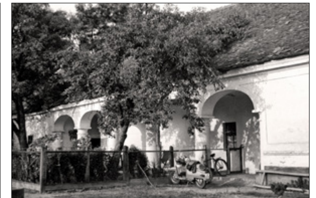
BALRA: Tömésfalú ház zsúptetővel Újnép-pusztán, 1960-ban. A szoba-konyha-kamra beosztású lakóház 1900 körül épült.
