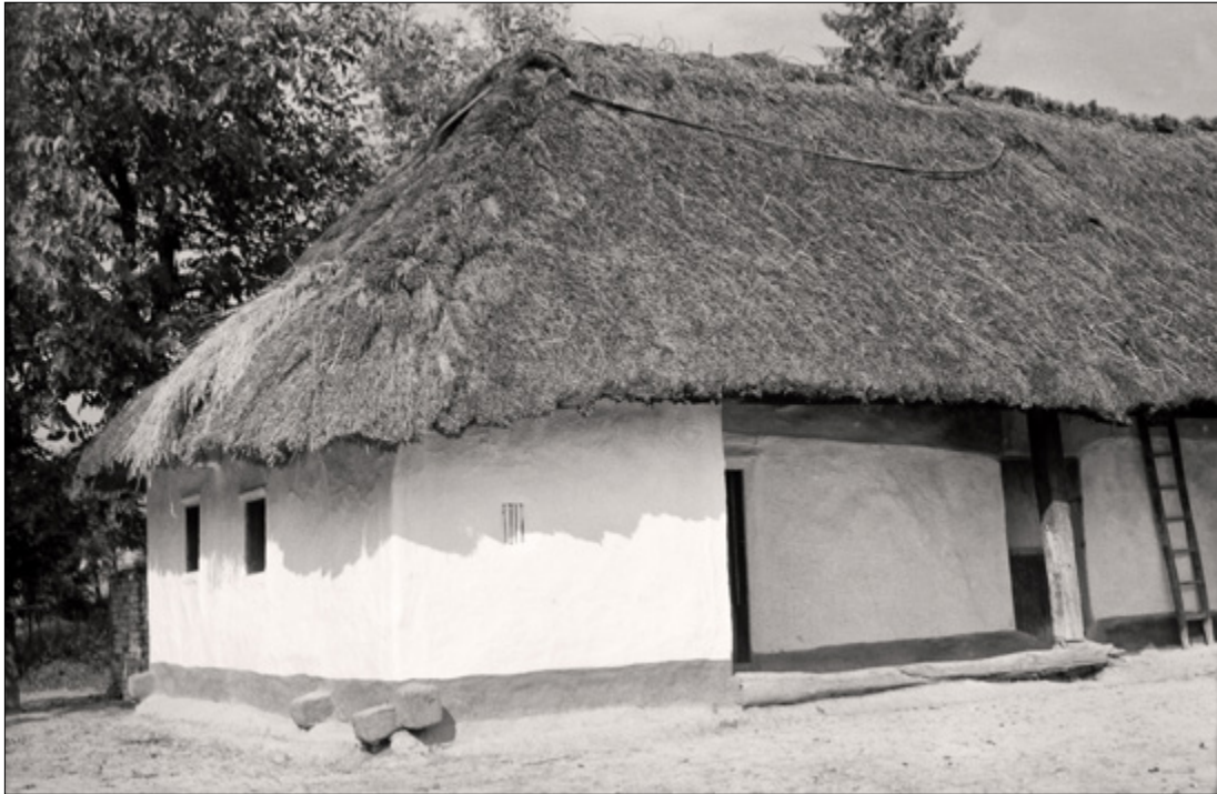
A Rózsa u. 19. szám alatti fatalpas, sövényfalú, füstöskonyhás zsúpos ház hátsó része az udvar felől fényképezve, 1960
