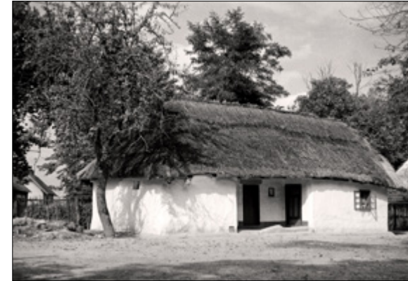
BALRA: 1810-ben épült, zsúptetős, füstöskonyhás, kémény nélküli lakóház a Rózsa utca 23. sz. alatt, 1960-ban. Fatalpas szerkezetű, sövényfalú, lopott tornácos épület.
