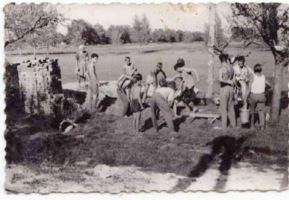
Zalaszentbalázi futballpálya munkálatai
